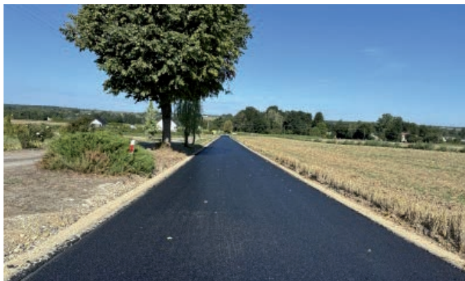
droga wewnętrzna w Strzyżewicach
