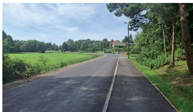
droga nr 107137L w Kietczewicach Dolnych
