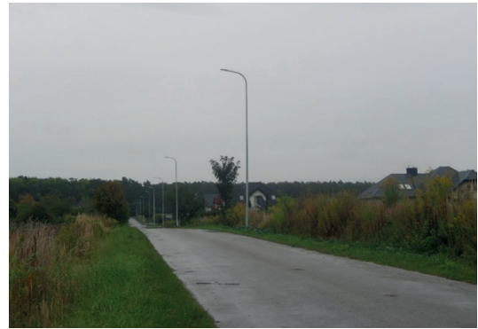
Oświetlenie drogowe w Żabiej Woli
