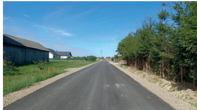
Droga w Bystrzycy Nowej po przebudowie
