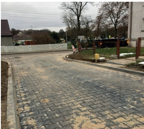
Droga wewnętrzna w Piotrowicach
