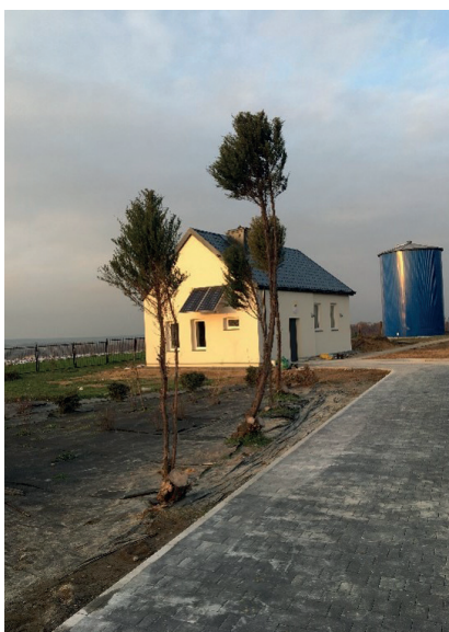
Ujęcie wody w Strzyżewicach
