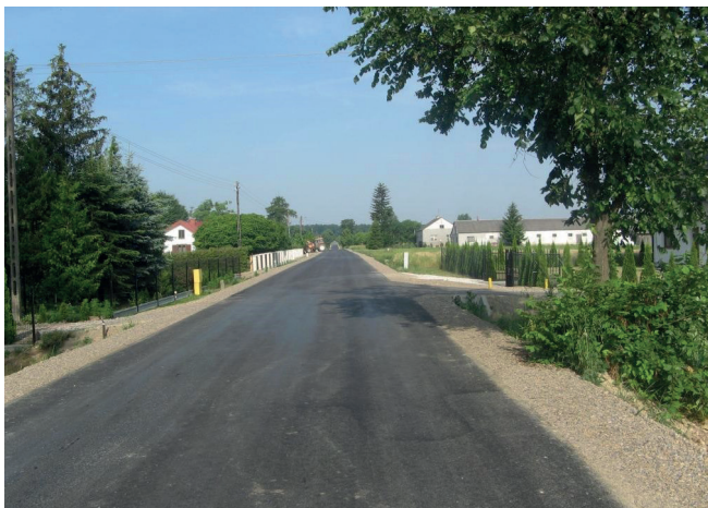
Droga w Kolonii Kietczewice Dolne
