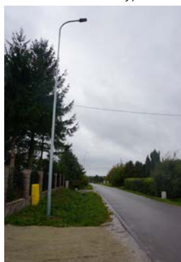
Budowa oświetlenia w Żabiej Woli
