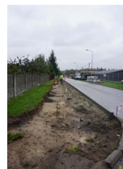
Budowa chodnika w Piotrowicach
