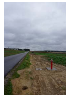
Budowa wodociągu w Żabiej Woli
