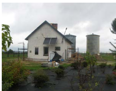
Modernizacja ujęcia w Strzyżewicach
