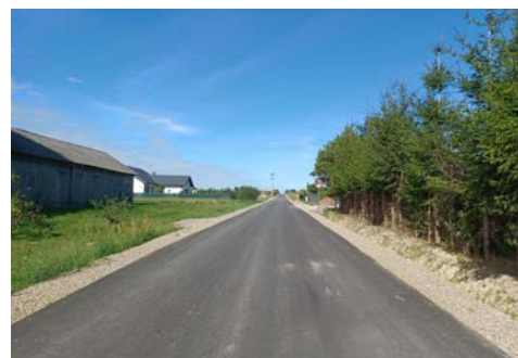
Droga gminna nr 112515L w Bystrzycy Nowej
