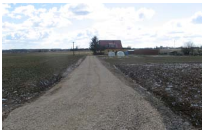
Droga wewnętrzna na działce nr 178 i 147 w Osmolicach Drugich
