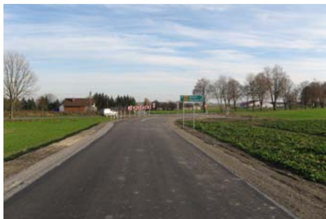
Droga nr 107130L w Bystrzycy Nowej
