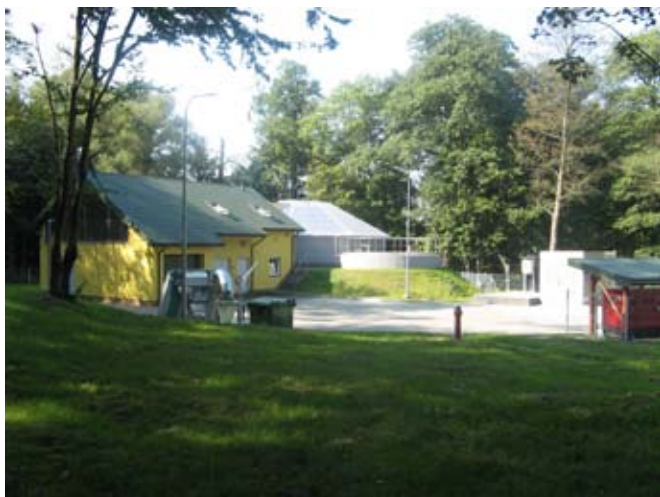
Oczyszczalnia ścieków w Pszczelej Woli
