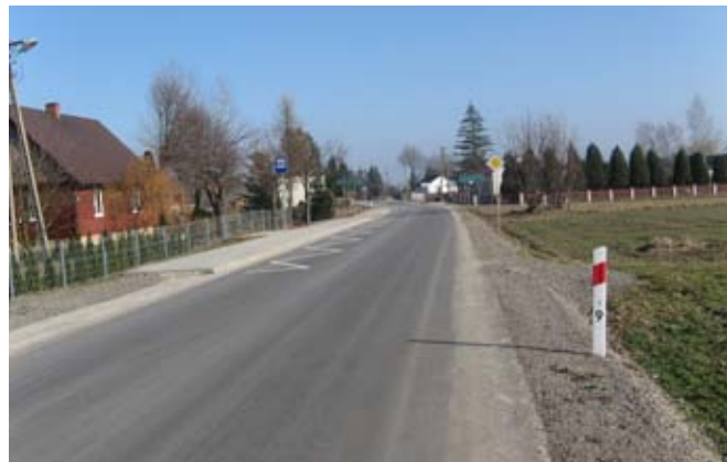
Droga powiatowa nr 2288L w Kietczewicach Pierwszych
