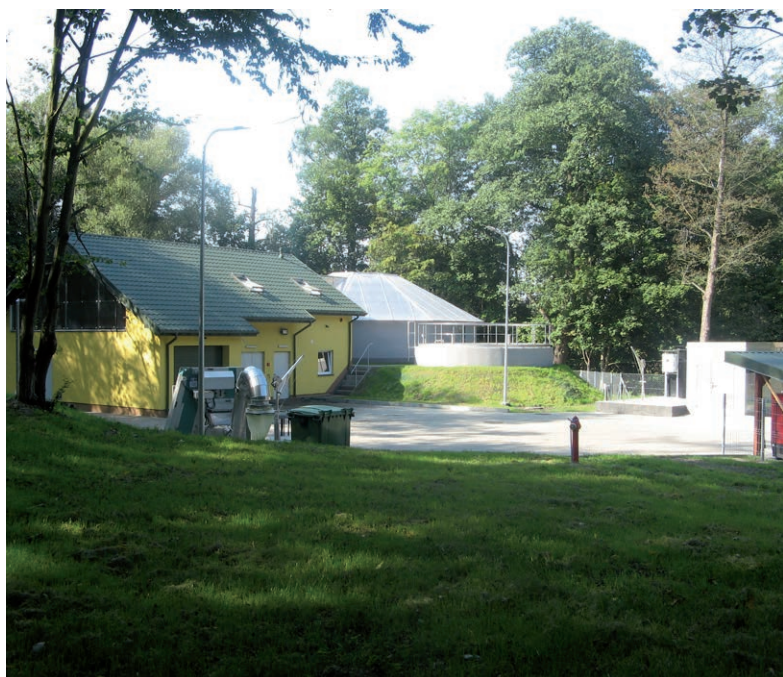
Oczyszczalnia ścieków w Pszczelnej Woli
