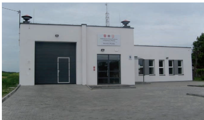
Świetlica wiejska w Bystrzycy Starej
