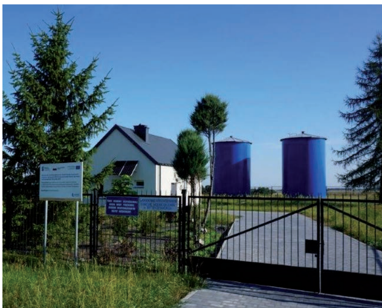
Modernizacja ujęcia wody w Strzyżewicach
