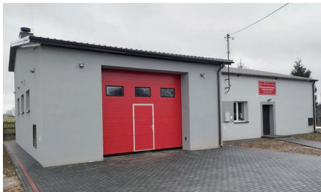
Rozbudowana remiza w Kietczewicach Górnych
