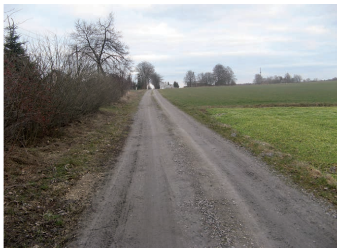
Planowa do przebudowy droga gminna nr 107143L w Kietczewicach Górnych
