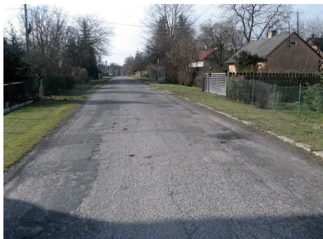
Planowa do przebudowy droga gminna nr 107133L w Pawłowie
