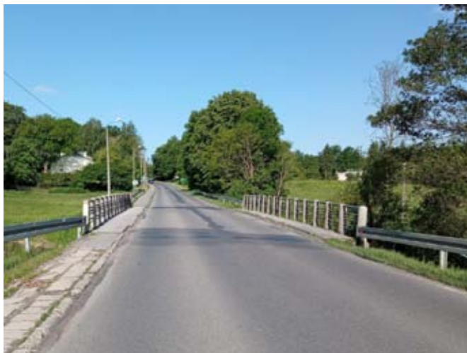
Planowany do budowy most w Osmolicach Pierwszych
